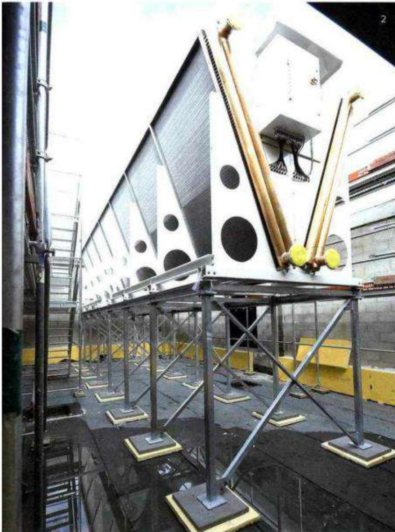
1 et 2. La trame technique, implantée non pas en sous-sol mais en toiture, selon un réseau constitué de l'épine dorsale et de galeries perpendiculaires, permettra une maintenance aisée et une évolution facilitée de l'hôpital sur lui-même. L'héliport prendra place à l'extrémité ouest, au-dessus des urgences.
